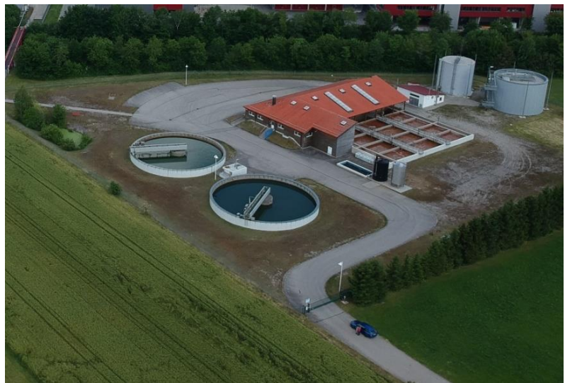
Kläranlage Hochland Werk: Schongau
