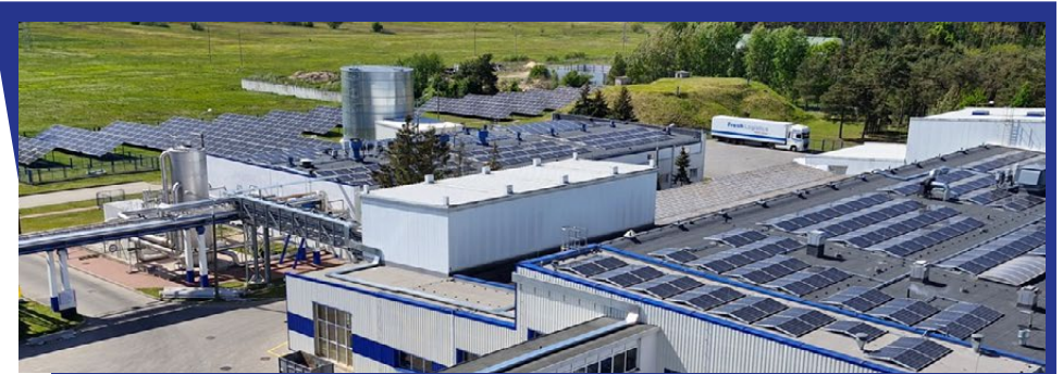
Fot. Farma fotowoltaiczna Zakład Węgrów
