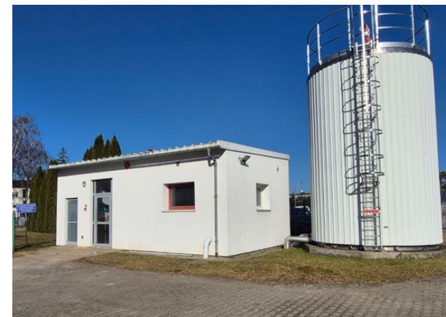
Fot. Stacja uzdatniania wody i studnia głębinowa Zakład Kaźmierz
