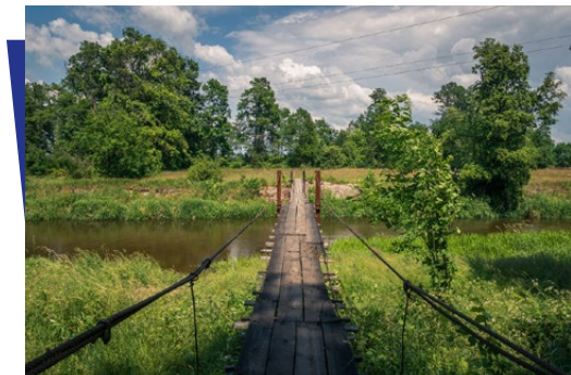
Fot. Wieszący most nad rzeką Liwiec w miejscowości Bednarze
